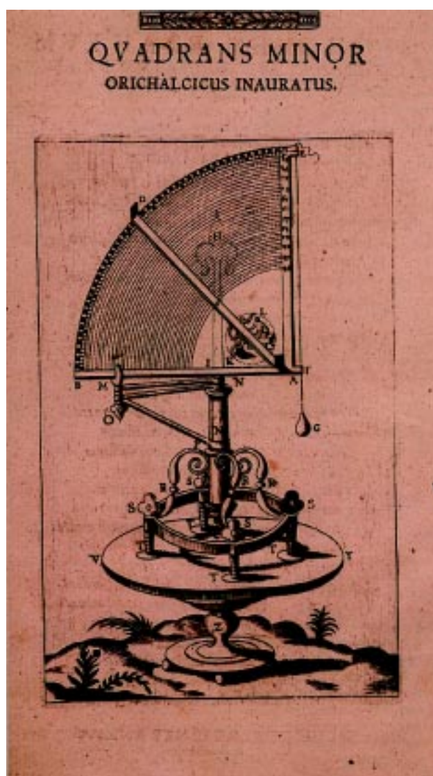
Fig. 9. Quadrante, com o raio de 390 mm, dispendo do nócio de Pedro Nunes. Gravura inserida na Astronomiae Instauratae Mechanica , ed 1602, de Tycho Brahe. Biblioteca da Ajuda, Lisboa.
